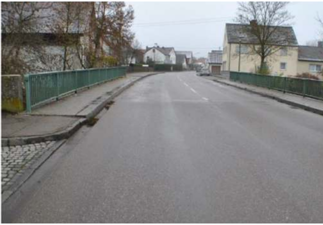
Wird umfangreich saniert: die Schmutterbrücke in der Dr.-Steichele-Straße.
