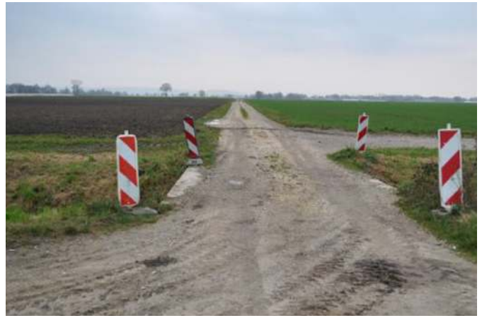
Auch die Durchlässe von Feldwegen werden grundlegend erneuert.
