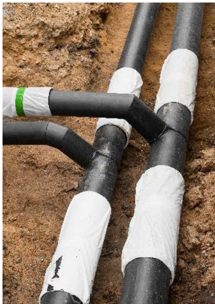
Mertingen erhält ein Fernwärme-Netz.
